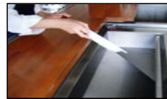
4-② 食堂放水場の光電管による間欠放水
