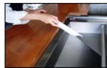
4-② 食堂放水場の光電管による間欠放水
