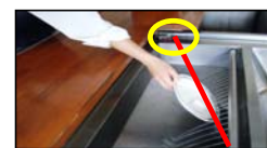
4-② 食堂放水場の光電管による間欠放水
